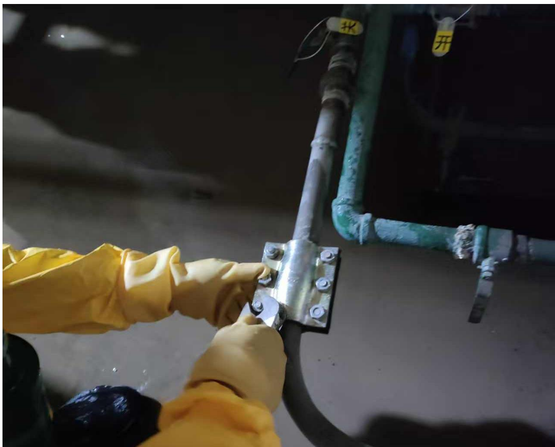
抢险组采用管夹封堵漏点
