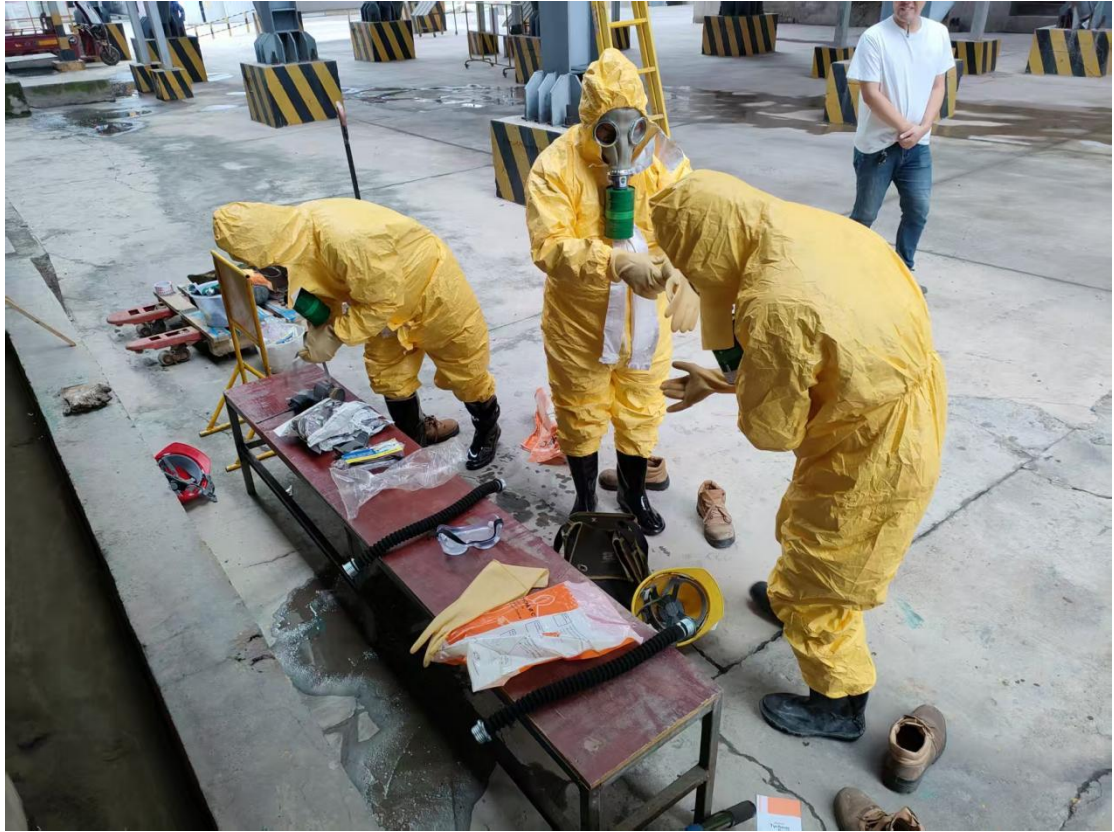
在抢救受伤人员的同时，应急抢险组抵达现场，进行抢修前防护装备穿戴
