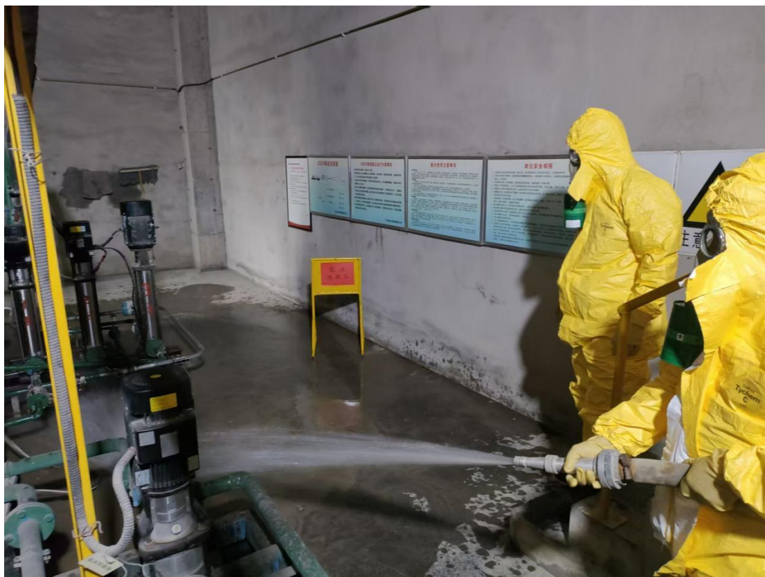
对漏点封堵抢修完毕后，对地面进行消防管大面积冲洗
